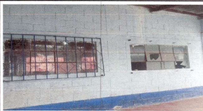
Foto 2: Sustitución de vidrios
